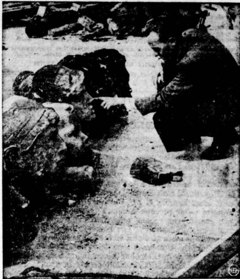
Un travailleur allemand semble ici compter les têtes des statues qui décoraient la vieille maison de 200 ans qu'avec ses camarades il vient de démolir dans le secteur soviétique. Cet édifice a été rasé pour permettre d'avoir une grande place où les rouges tiendront leurs manifestations.
