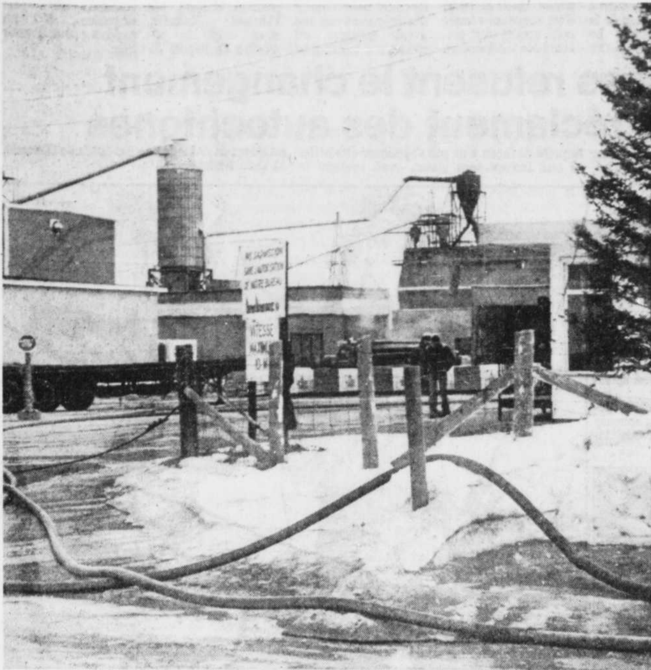
Les pompiers volontaires de Luceville, aidés par un camion-pompe et six pompiers de Rimouski, ont pris quatre heures à maîtriser l'incendie dans un séchoir de la scierie Lulumco, hier matin.
