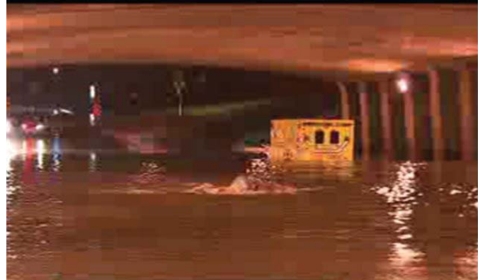
Ambulance coincée dans le viaduc Salaberry inondé de l'arrondissement d'Ahuntsic-Cartierville, le 10 août 2011 Crédit : © Archives Radio-Canada
