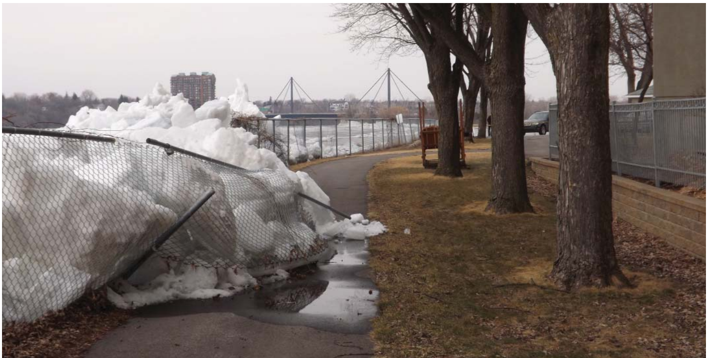
Les glaces de la rivière des Prairies ont défoncé la clôture derrière la résidence Berthiaume-du-Tremblay, arrondissement d'Ahuñsic-Cartierville. (18.04.2014) Crédit : © Philippe Rachiele – journaldesvoisins.com
