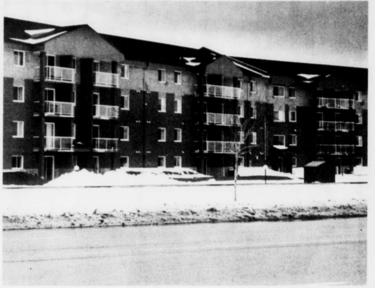
Photo La Tribune par Maurice Cloutier Pour ce seul édifice de condominiums, le crédit de taxes, bon pour trois ans, permet à la compagnie Construction Jacques de sauver quelque 50,000 $ en taxe foncière.
