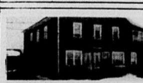
Maison de 4 logements 409-A et B, 411-413, rue Lachance, Ste-Agnès, Rimouski
