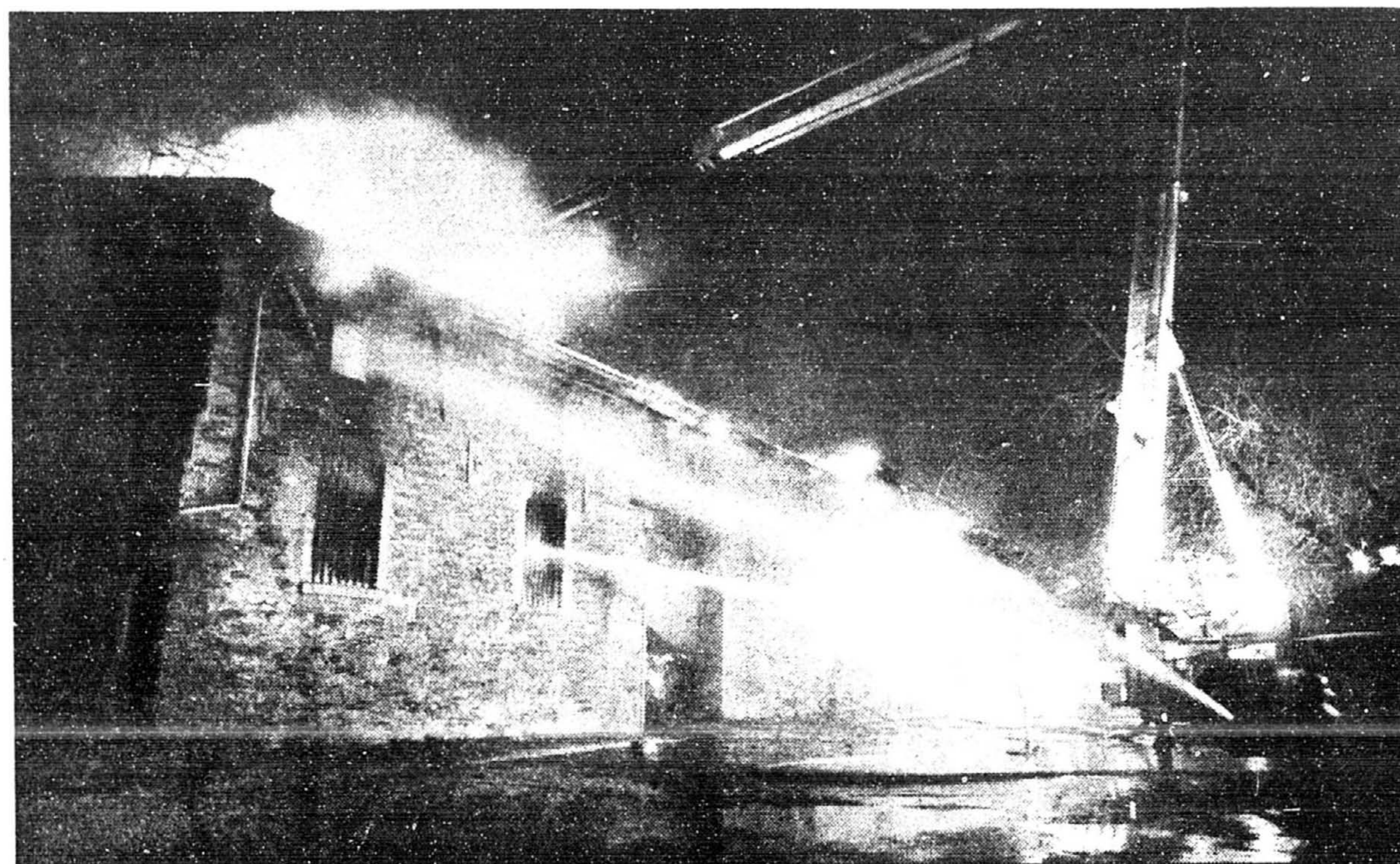
L'entrepôt de la compagnie Caverhill, Learnmont, situé dans le Vieux-Montréal et dont la construction remonte au siècle dernier, n'est plus que ruines après le gigantesque incendie qui l'a ravagé samedi soir.
