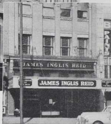
Immeuble de James Inglis Reid Ltd., Vancouver, C.B. Architectes: McCarler & Nairne. Couvreurs: Pacific Sheet Metal Works Ltd., (Maintenant la Westeel Products Ltd., à Vancouver)
