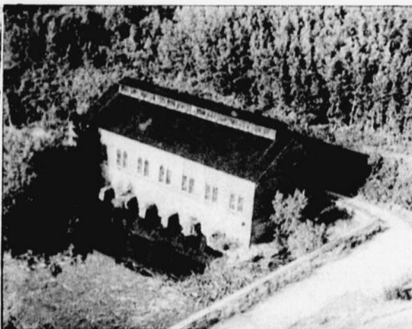
Centrale N.A.C. érigée en 1900.
