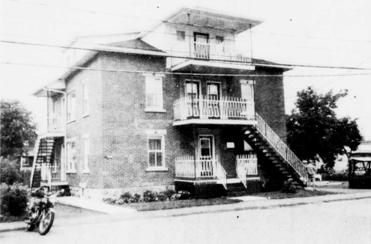
La coopérative Le Duo a procédé hier après-midi à l'inauguration du premier immeuble dont elle est propriétaire, au 1020 de la rue Goupil à Drummondville.
