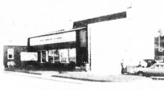
Deux images du "coin du pont", comme on l'appelle l'entrée nord de la paroisse Saint-Ludger.
