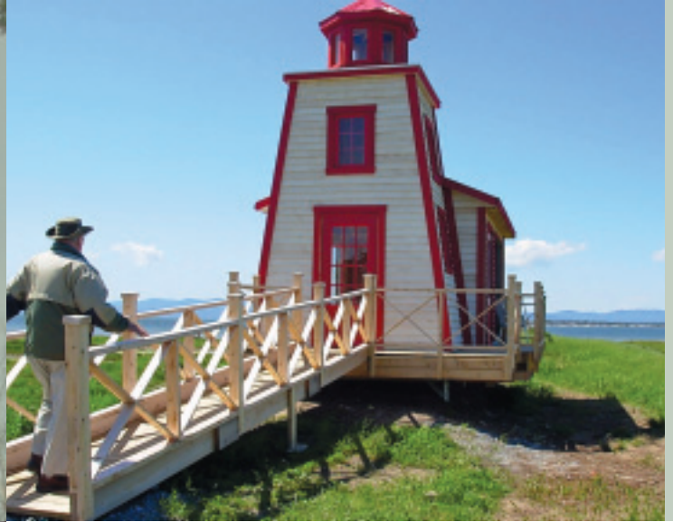
Parc de l'Ancien-Quai à Saint-André de Kamouraska
