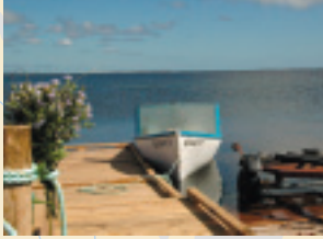
Rampe de mise à l'eau à la pointe des Canots, Îles-de-la-Madeleine
