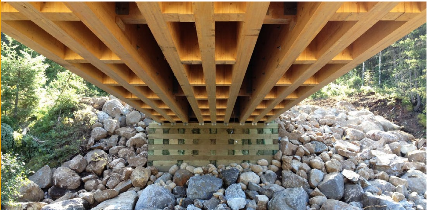
Pont forestier en bois à poutres lamellé-collé, Rivière Barnabé, municipalité de Saint-Ludger-de-Milot. Photo : Nordic Structures
