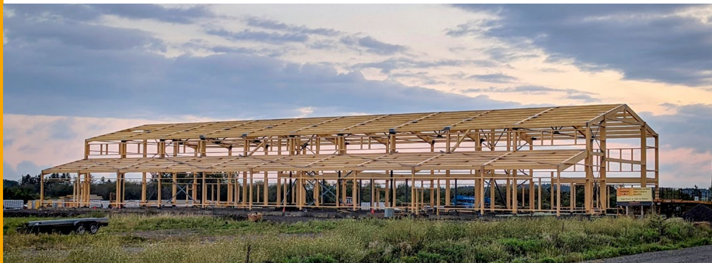
Bâtiment industriel en bois lamellé-collé, Ecorad, municipalité de Saint-Jean-Port-Joli
