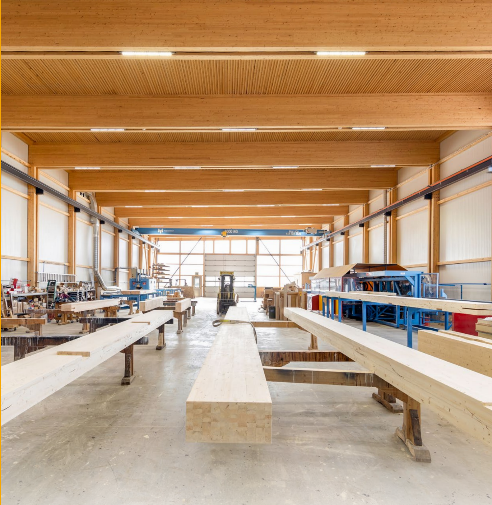
Bâtiment industriel en poutres de bois lamellé-collé et panneaux de bois lamellé-cloué, usine Charpentes Montmorency, ville de Saint-Raymond. Photo : Dave Tremblay
