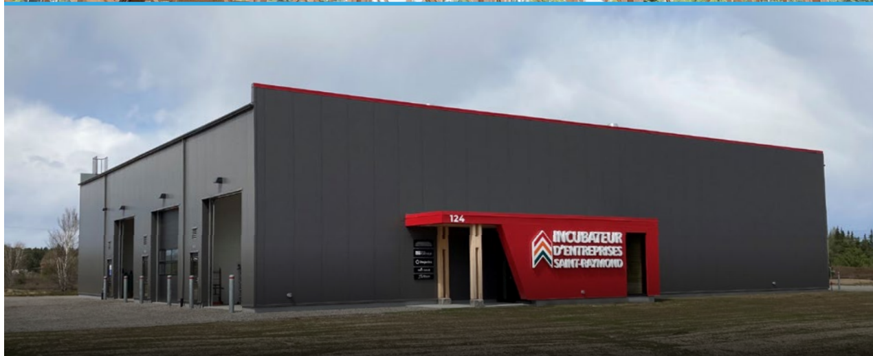
Bâtiment industriel composé d'une structure de bois en placage stratifié apparent (LVL) et d'une toiture en panneaux de bois lamellé-cloué, Corporation de développement de Saint-Raymond, ville de Saint-Raymond. Photos : Corporation de développement de Saint-Raymond
