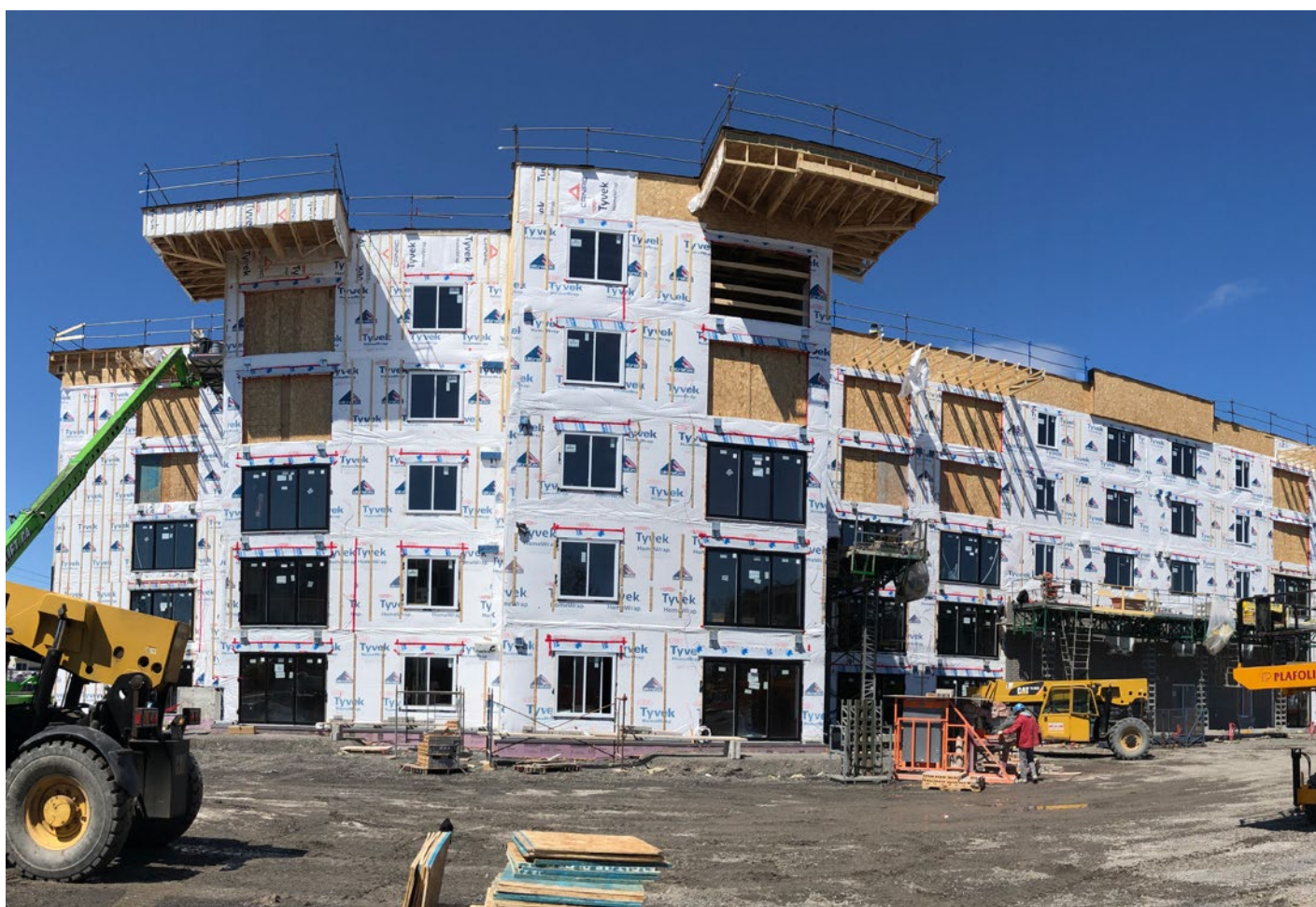
Bâtiment d'habitation multifamilial en structure d'ossature légère en bois, Logisco, ville de Val-Bélair. Photo : Logisco
