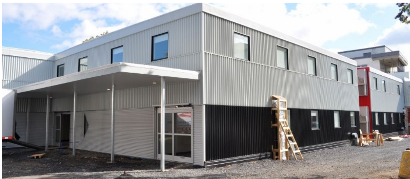
Bâtiment hospitalier préfabriqué d'ossature légère en bois, Centre d'urgence de l'Institut de Cardiologie de Montréal, ville de Montréal. Photo : RG Solution en partenariat avec MobilFab et ATCO
