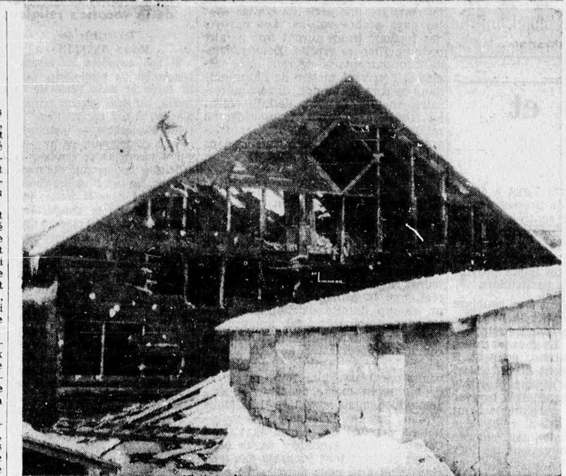
LES FLAMMES ONT DETRUIT samedi soir l'entrepôt de la ferronnerie J.-A. Lalonde, sur le boulevard Saint-Joseph, à Wrightville. Les sapeurs de la cité de Hull ont eu fort à faire pour venir à bout de l'incendie et pour empêcher que le feu ne se propage aux bâtiments voisins. Les dommages subis au cours de cet incendie s'accroissent probablement à $35,000.
