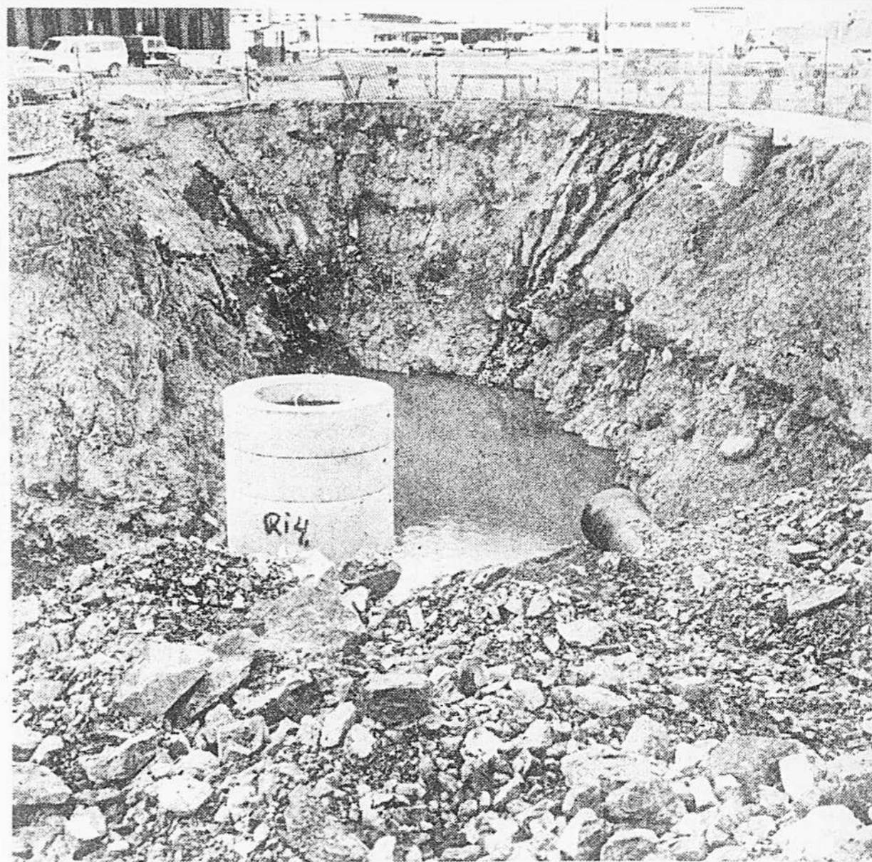
La fuite d'essence a nécessité la construction, au coût de $250,000, d'une nouvelle station de pompage dont les travaux sont commencés.
