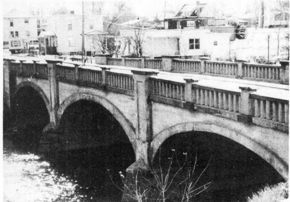
Le ministère des Transports a accepté d'effectuer les réparations demandées par la ville au pont qui enjambe la rivière Nicolet sur le boulevard Gamache.
