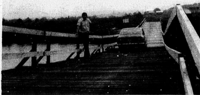
Afin de donner aperçu de la largeur des ponts, le surintendant des travaux, M. Jean-Marc Dessureault, en a fait une démonstration en se dirigeant sur ce pont avec son automobile.
