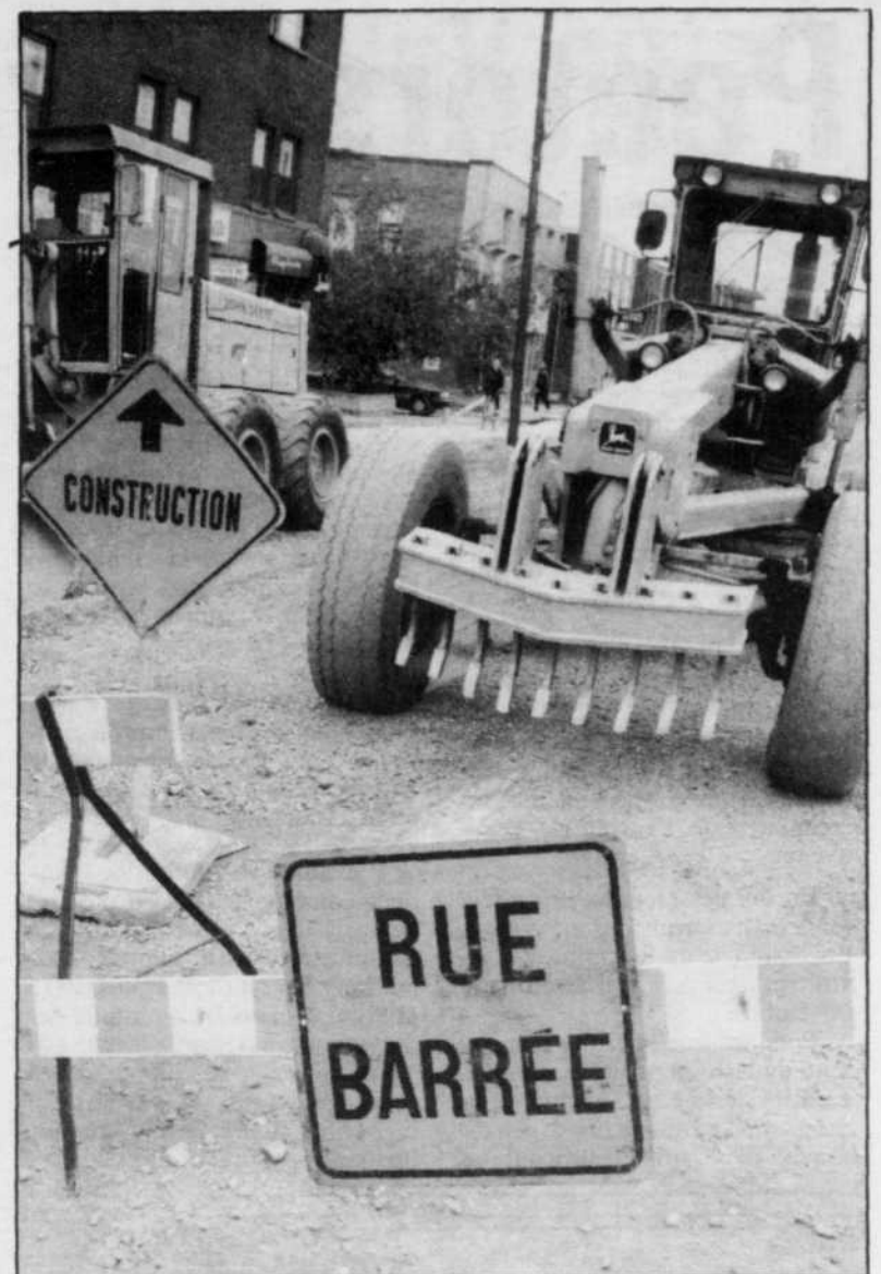
Les travaux préparatoires au pavage se sont poursuivis hier sur le tronçon St-Charles-Laval. Le pavage sera effectué la semaine prochaine.
