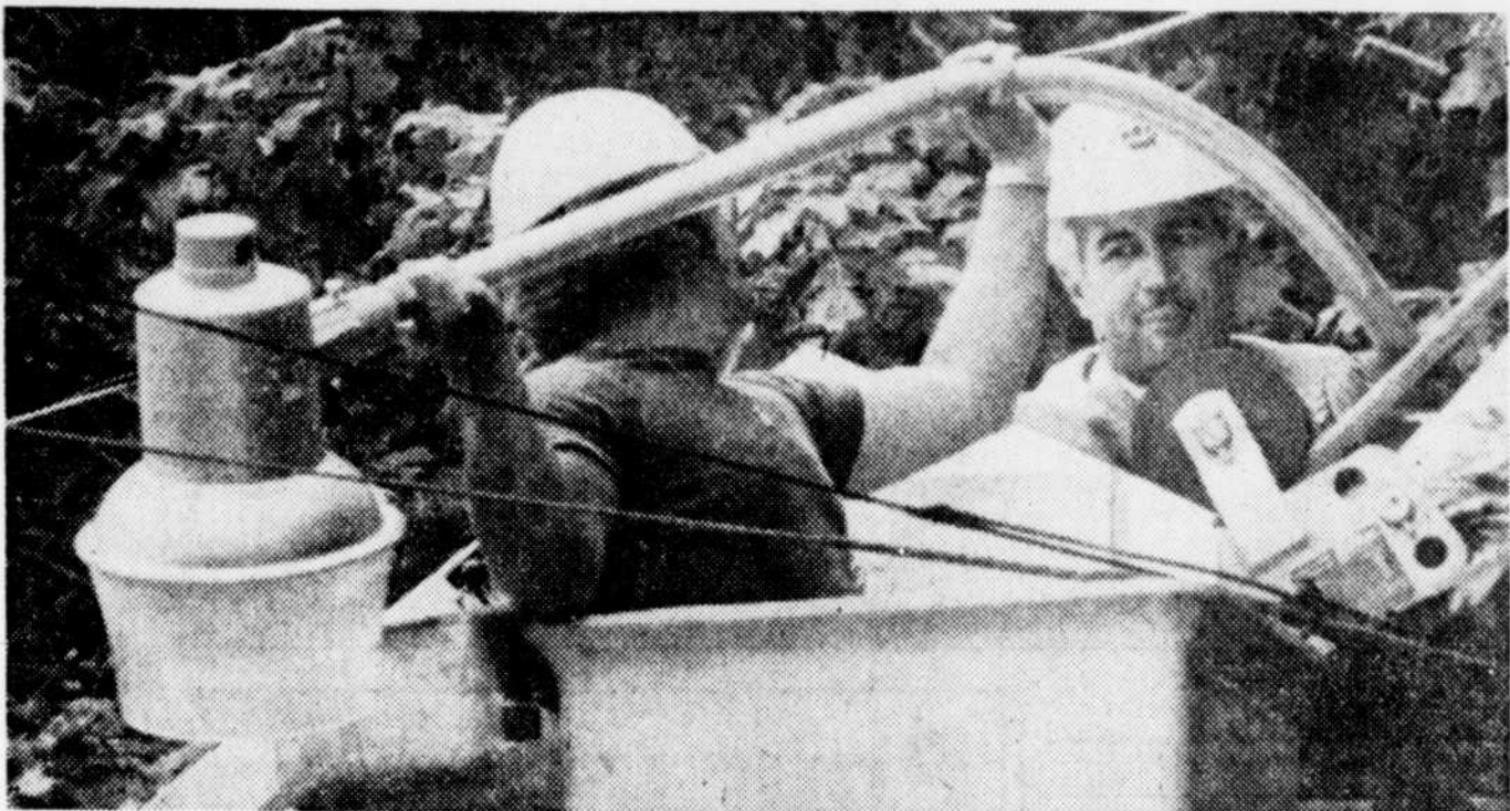
Le maire Jean Pelletier a procédé, l'été dernier, à l'inauguration d'un réseau moderne d'éclairage des rues de Québec, installé au coût de $1,600,000.
