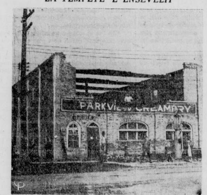
La tempête qui s'est abattue sur l'Ontario la semaine dernière a été particulièrement violente à St-Mary's et à Woodstock. Voici une conspéculation de St-Mary's dont le vent a enlevé le toit en ensevelissant le propriétaire sous les débris de bois et de briques. — Ce malheureux, William William Bruce, s'en est cependant tiré avec des blessures légères.
