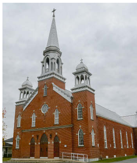
Selon le maire Michel Aucoin, l'église de Sainte-Victoire nécessite quelques travaux, dont certains au clocher et aux fenêtres. Photo Pascal Cournoyer | Les 2 Rives ©
