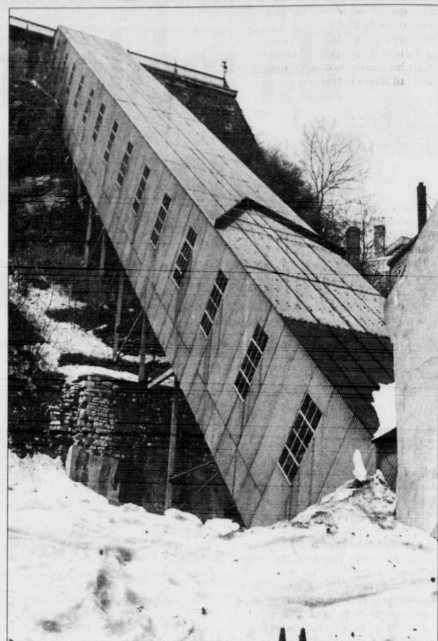
Sur cette photo datant de 1972, on aperçoit des installations jugées «désuètes et épuisantes», ainsi que le rapportaient les journalistes à cette époque. Un rapport recommandait que l'«ascenseur» soit remplacé par un escalier roulant ou un ascenseur panoramique dans un tube de verre. Ce service devait être gratuit.
