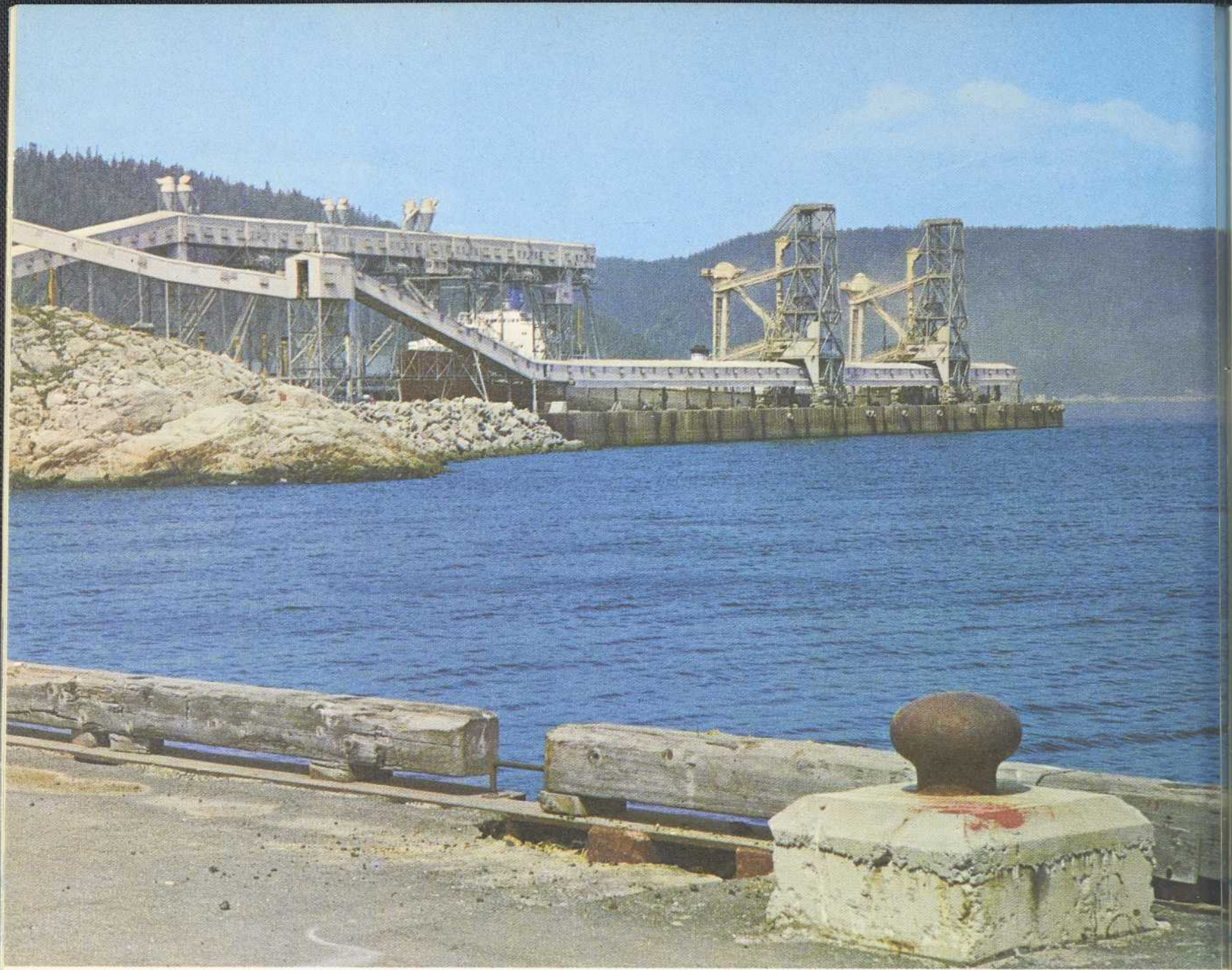
Installations portuaires à Baie-Comeau. Harbour facilities at Baie-Comeau.
