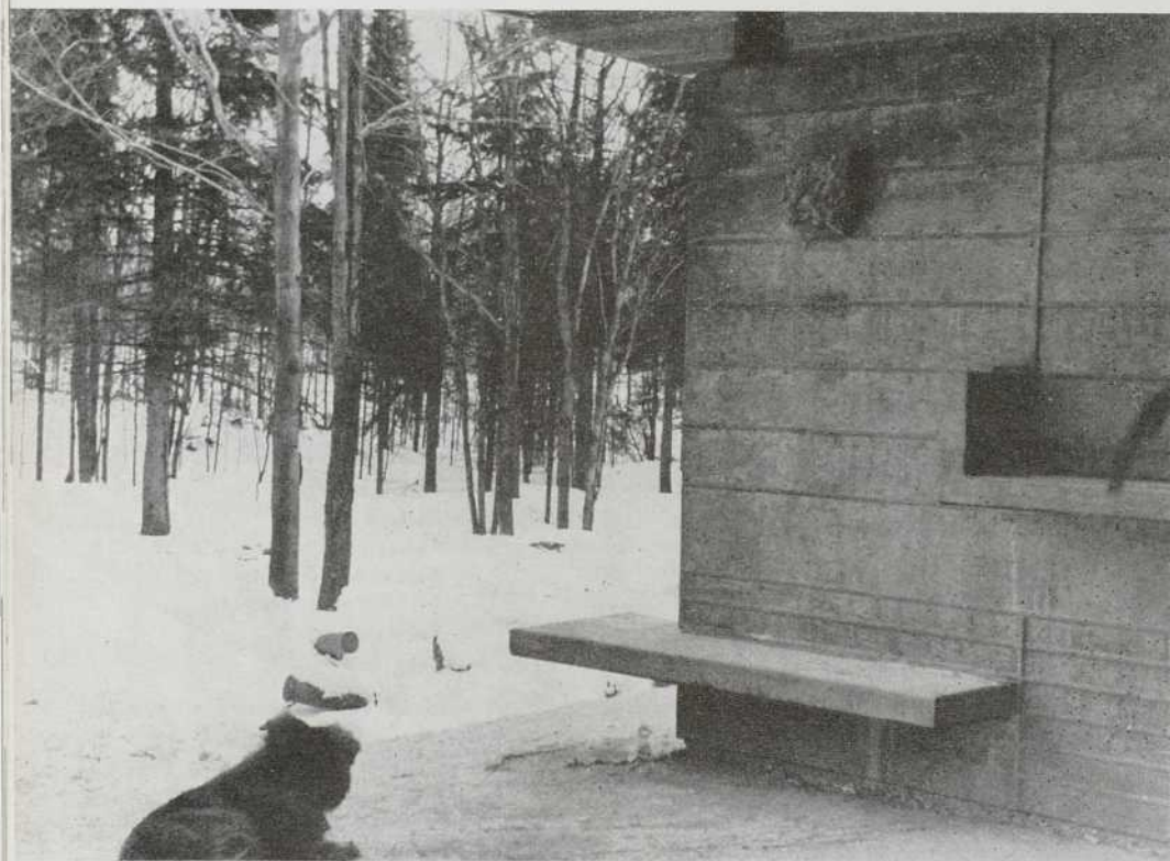
3 3 — Un contreventement extérieur en béton, formant banc et étagère à fleurs. Voir ci-dessous le dessin du coffrage.
