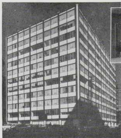
Fuller Bldg. - Arch.: Propre personnel. Const.: Fuller Construction Co. Ltd.
