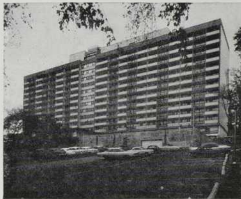
Champlain Towers - Architectes : Bemis, Murray & Associates; Constructeur : R. Campeau.
