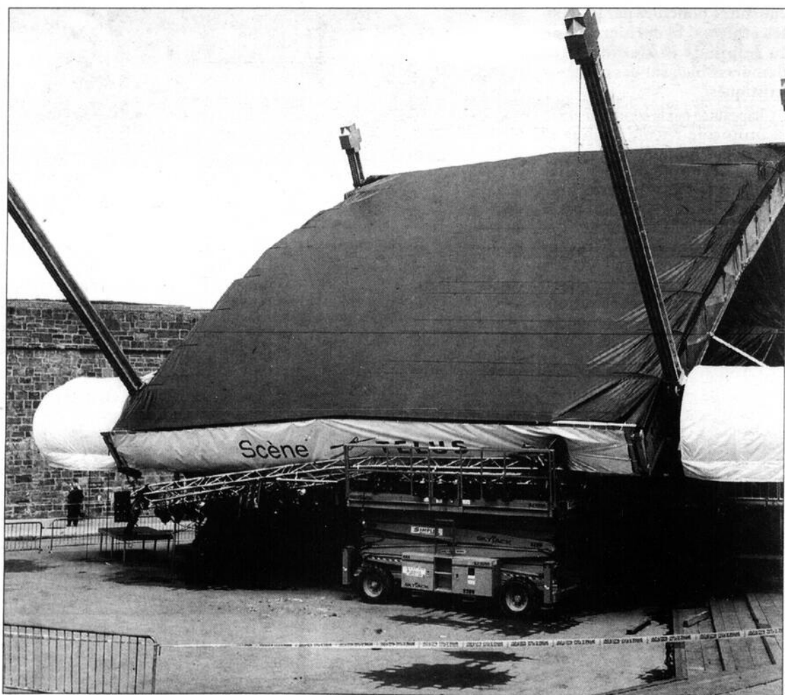
Une scène du groupe Berger s'est effondrée à Québec, le 30 juin. Personne n'a été blessé.
