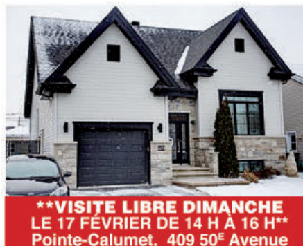
Impeccable contemporaine 11 pces 3cac, 2 sdb, planchers de bois de bambou au rdc, foyer 4 faces situé entre le salon et la salle à manger, immense sous-sol aménagé, cinéma maison, garage intégré, piscine hors-terre et ++ À voir !!! Centris 15554531 424 900 $
