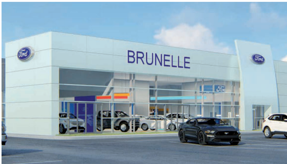
Un aperçu du concessionnaire Brunelle Ford, une fois les travaux de modernisation terminés.
