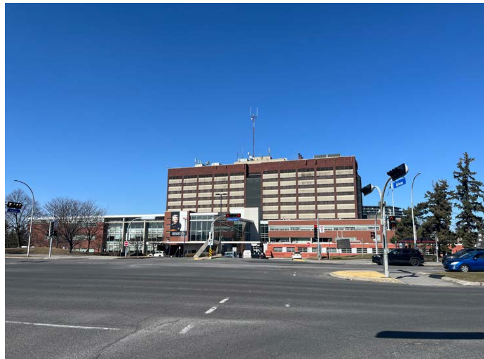
L'agrandissement de l'urgence de l'Hôpital Pierre-Boucher est toujours prévu. (Photo : Marie-Pier Ouellet)
