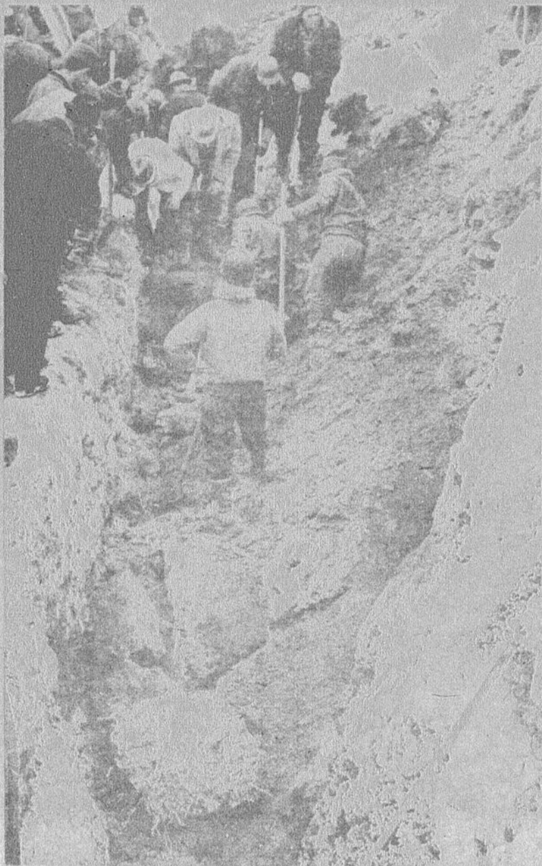
La population de la Beauce, celle de St-Georges en particulier, a encore frais à la mémoire le terrible accident survenu à Jersey Mills le 6 décembre. Trois hommes furent tués dans un éboulement de terrain pendant le creusement d'une tranchée pour les tuyaux d'aqueduc. Les victimes étaient MM. Donat Bernard, Donia Gilbert et Yves Poulin, âgés respectivement de 58 ans, 18 ans et 19 ans. Un quatrième employé, M. Bertrand Lessard échappa de justesse à la mort, demeurant enseveli jusqu'au cou pendant plus d'une demi-heure. La scène ci-dessus fut photographiée au moment où on retirait un corps des débris. (Photo R. Gagnon)
