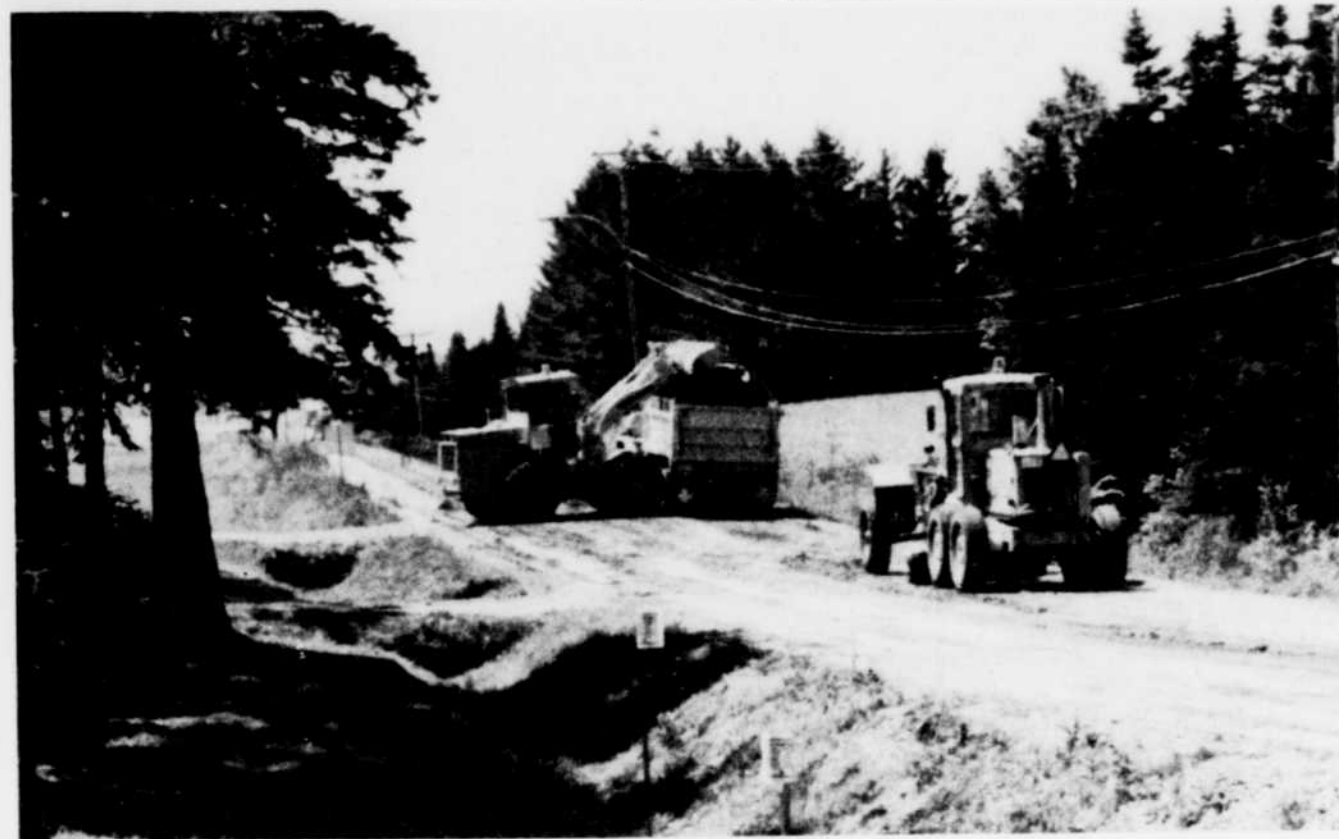
Le béton bitumineux recyclé qui, non loin de Magog, a été étendu, l'an dernier, sur une route secondaire a dû être enlevé parce qu'il s'était ridé sous l'effet de la chaleur. La route recevra un nouveau revêtement dans quelques jours.
