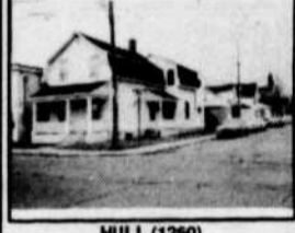
HULL (1260) 83 St-Joseph. Commercial. Bureaux 2 étages relié par escalier intérieur. Bâtisse solide. Ample stationnement avec le garage enlevé. YVON BRUNET 771-1110
