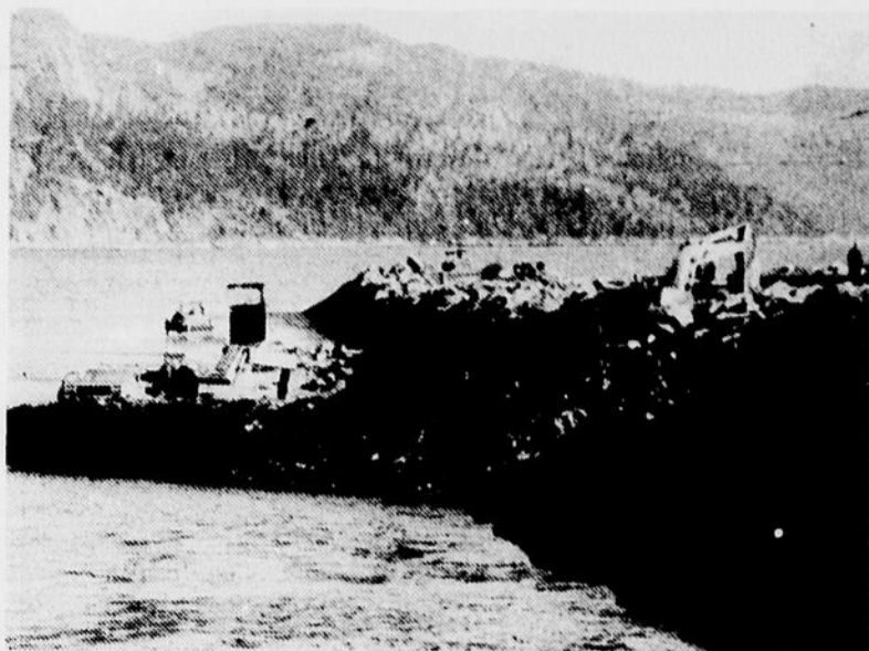
SEDIMENTATION — Les travaux de réaménagement, en voie de réalisation à l'embouchure de la Rivière-à-Mars, à La Baie, permettront notamment de limiter les effets de sédimentation près des quais Duncan et Powell.
