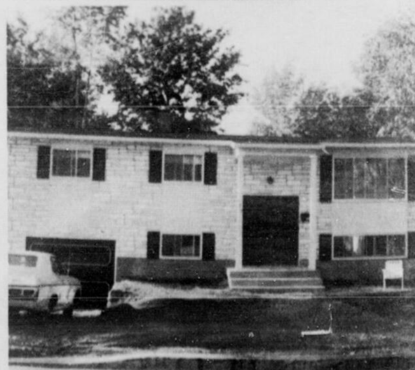
La maison modulaire est maintenant en place.
