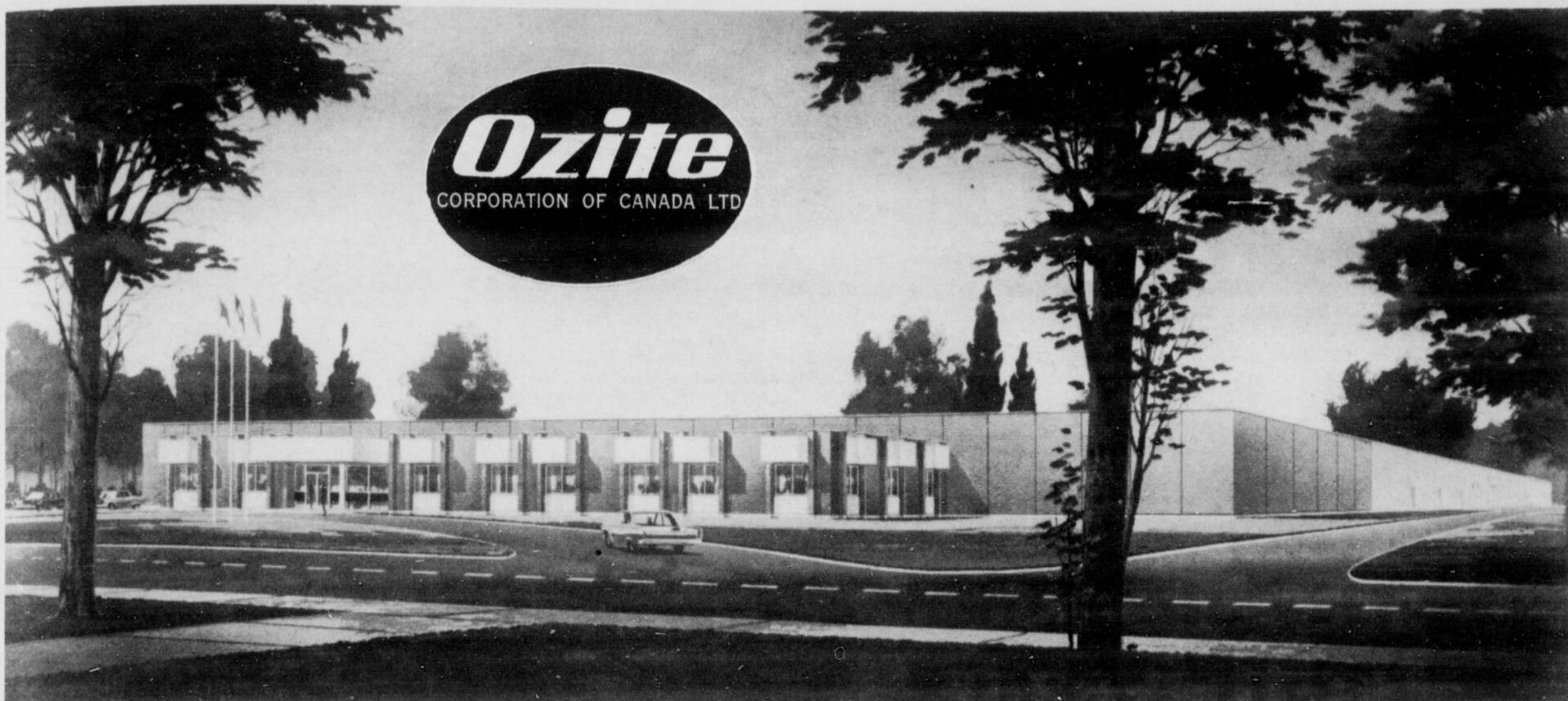
L'usine moderne Ozite bâtie en 1968 sur la rue Grand Bernier.
