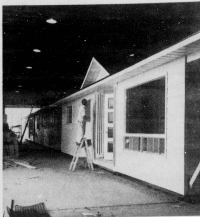
Montées sur roues et rails les sections de maisons reçoivent leur peinture extérieure.
