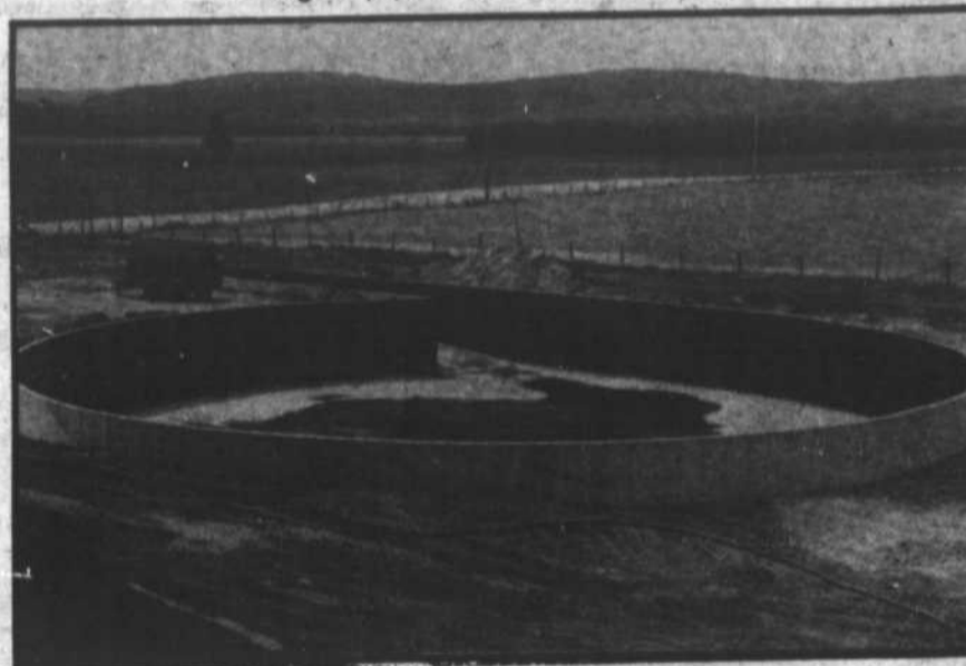
Plate-forme à fumier.
