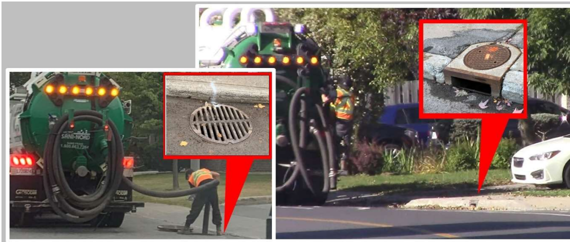
Deux photos illustrant des puisards et leur nettoyage, prises par le Bureau de l'inspecteur général
