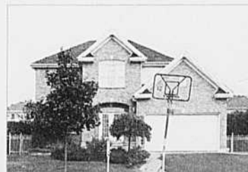
Offre luminosité et espace! Garage double largeur. Belle et grande cuisine avec coin banquette. Salle familiale au RDC et foyer au propane. Cinéma maison au sous-sol et vaste salle de jeux. Haie mature, piscine creusée.
