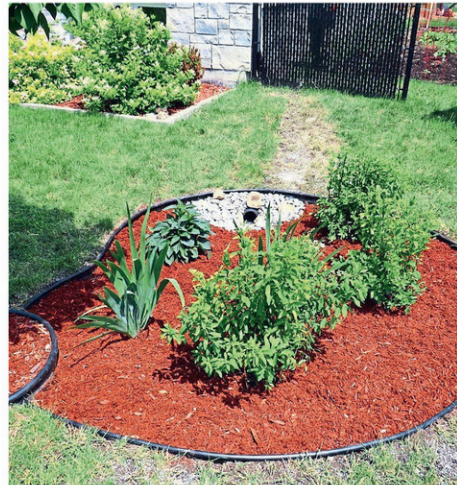
Un jardin de pluie de la rue Hébert. Un tuyau enfoui dans le sol permet de relier la gouttière au jardin.
