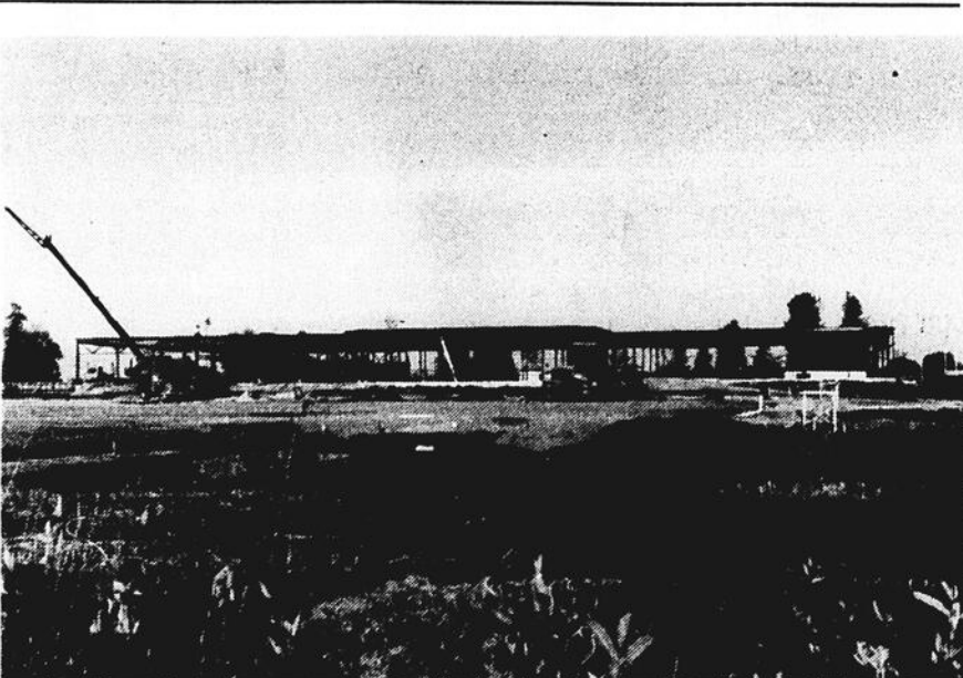
Les travaux vont bon train au nouveau centre administratif d'Hydro-Québec à Valleyfield, sur le boulevard Mgr. Langlois. Des investissements de plus de 10 millions de dollars sont nécessaires pour abriter les nouveaux locaux.
