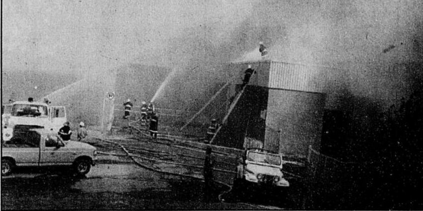
Un incendie d'origine accidentelle a lourdement endommagé la polyvalente de Gaspé hier.
