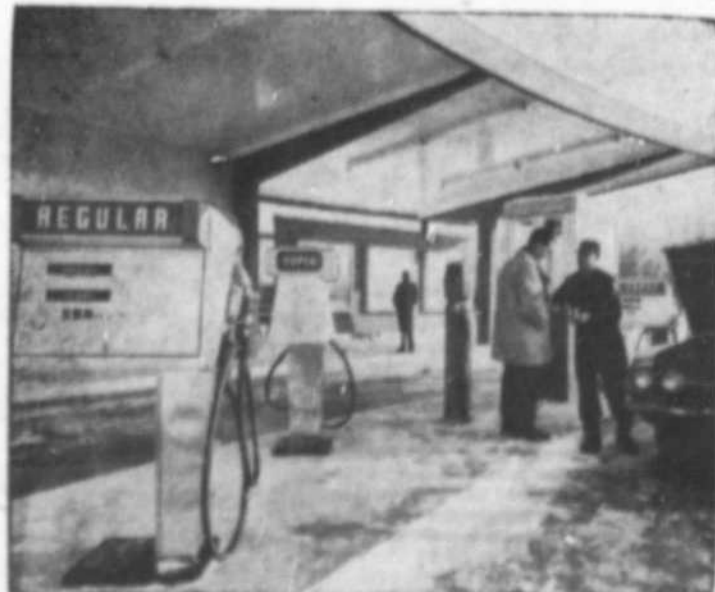
Ces débiteurs d'essence d'un modèle récent commandent à distance les pompes installées au-dessus des réservoirs souterrains
