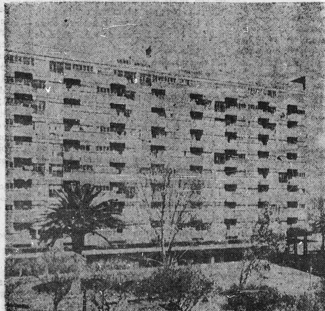
Ces deux immeubles donnent une idée
