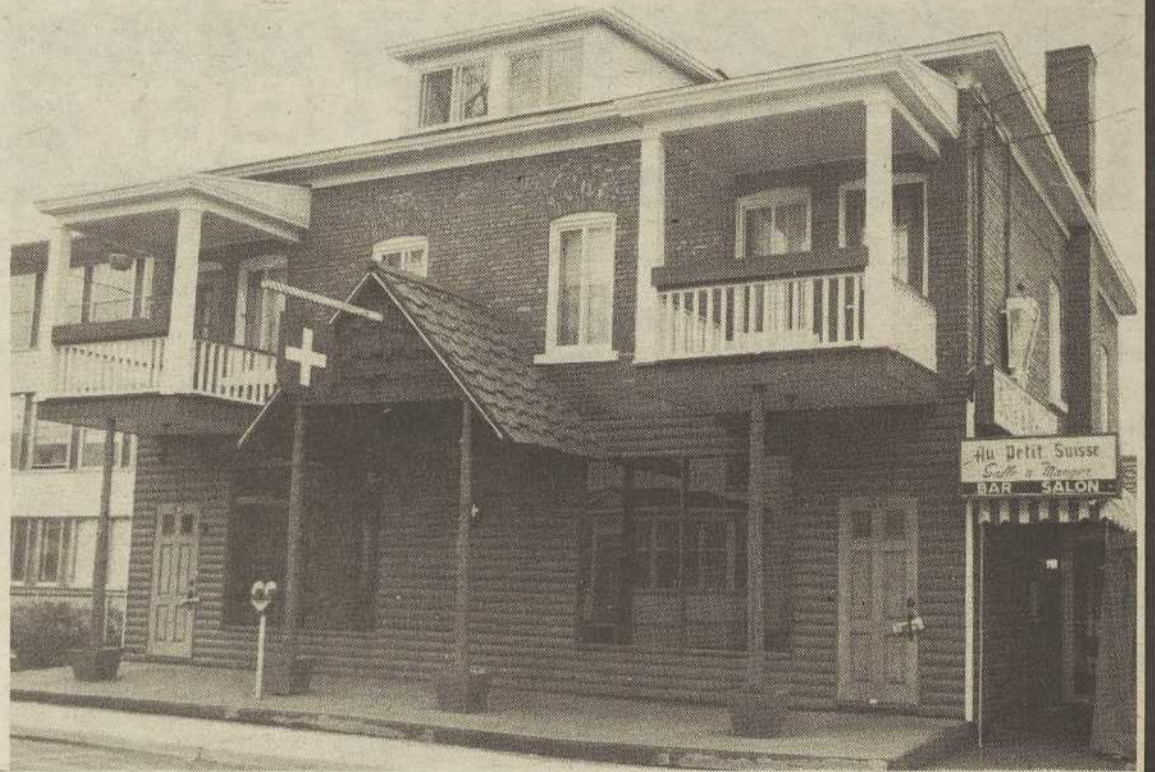
Il aura fallu un travail acharné durant 18 heures pour débarrasser le restaurant le Petit Suisse des inconvénients d'un déversement accidentel d'huile à chauffage sur le plancher du sous-sol.
