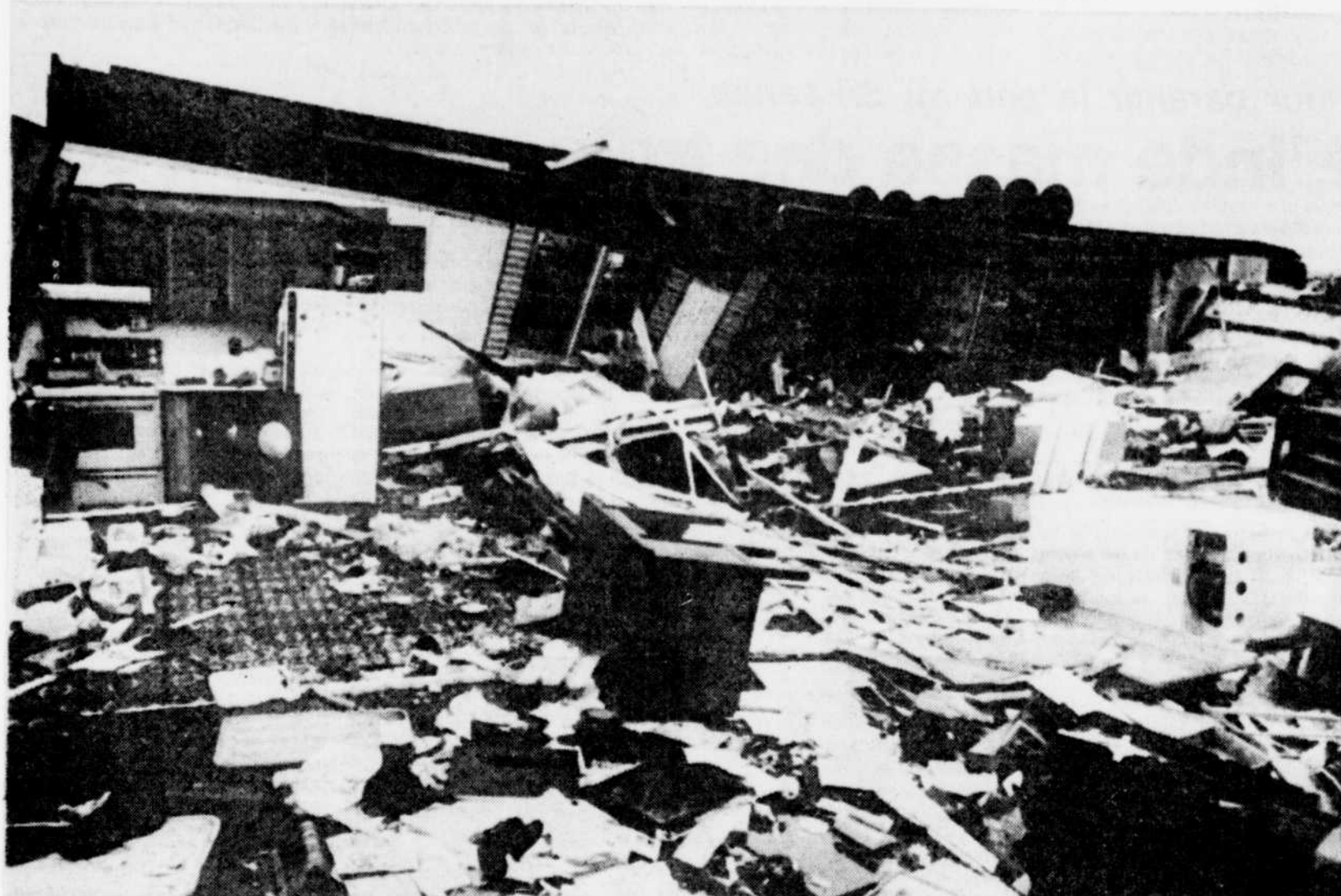
D'importantes mesures de sécurité ont été déployées dans la nuit de vendredi à hier afin d'éviter le pillage des propriétés démolies partiellement ou entièrement. Déjà, dans la nuit, les policiers ont dû écarter des lieux des gens par trop curieux dans leurs agissements; on croyait avoir affaire à des pilleurs.
