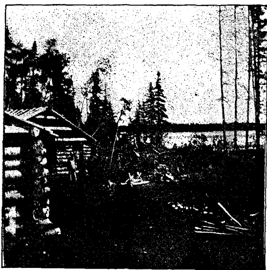
CHANTIER DU LAC PLANTIN
