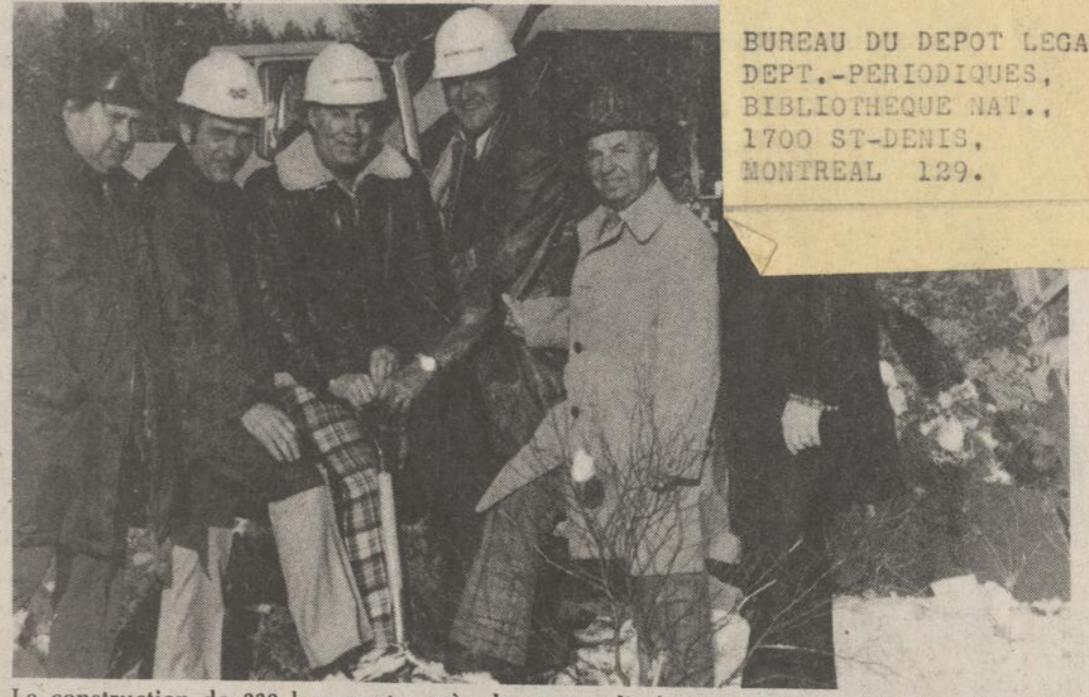
La construction de 230 logements, près du centre d'achats Les Galeries de Granby, a été dévoilée, hier, par M. Marcel Croteau, président de la firme Marcel Croteau Construction, de Granby. Une première pelletée de terre a été donnée sur le terrain où s'élèveront un immeuble de 18 logements, MM. Eugène Brodeur, inspecteur en chef des bâtiments et coordonnateur de la rénovation urbaine de la ville, Gilles Cadorette, conseiller du quartier, Marcel Croteau, promoteur du projet, Paul-O. Trépanier, maire de Granby, Jean-Paul Bernier, directeur de l'Assurance-vie Desjardins, et Yvon Campbell, inspecteur en bâtiments de la ville, ont participé à la cérémonie. (Photo C-Line Jobin)
