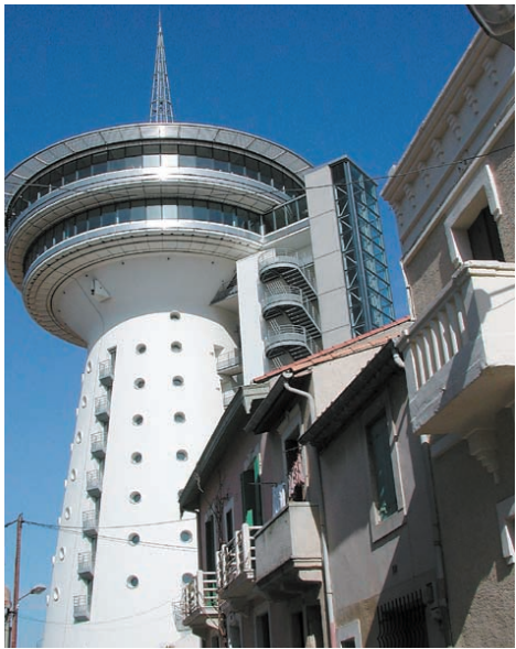
Le château d'eau de Palavas-les-Flots a été réhabilité en centre des congrès.
