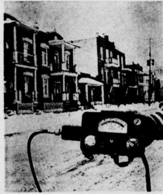
Rue Berri, en face du numéro 7215, lundi 9 janvier. Concentration de 85 p. 100 de gaz pur au-dessus de la conduite principale de gaz. "Ils (la Corporation) sont chanceux qu'il ne gèle pas, nous a dit l'un des techniciens qui nous accompagnait, car quand il gèle, le sol travaille et cela accroît les infiltrations". Selon nos renseignements, on connaît l'existence de cette fuite depuis environ trois semaines.
