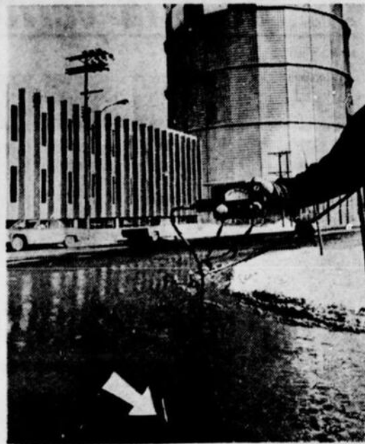
Intersection Lafontaine et du Havre, tout près du grand réservoir de gaz naturel Hochelaga, lundi 9 janvier. Concentration de 42 p. 100 de gaz dans le trou d'homme de l'aqueduc. De l'autre côté de la rue, une tranchée a été ouverte pour laisser le gaz s'échapper à l'air libre. Cela pue à plein nez. Renseignements pris, cette fuite existe depuis le début de la grève.
