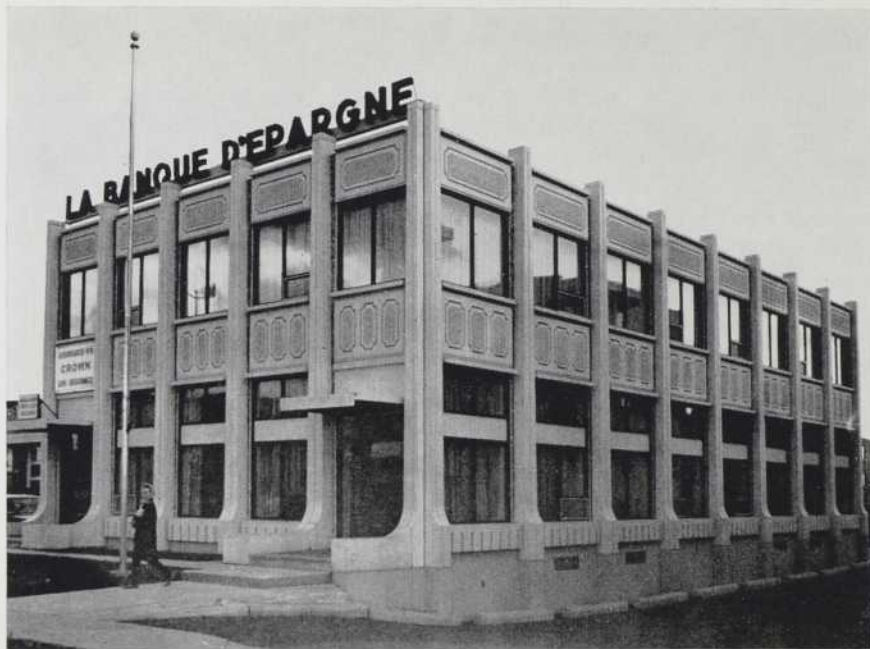
Succursale de la Banque d'Épargne de la Ville et du District de Montréal, Anjou. Ici la charpente se découvre avec un aspect de solidité et tout en visant à "tourner en ornement les parties nécessaires à soutenir un édifice" (Fénelon). Les virtualités du béton armé concourent à l'élaboration de proportions harmonieuses.
