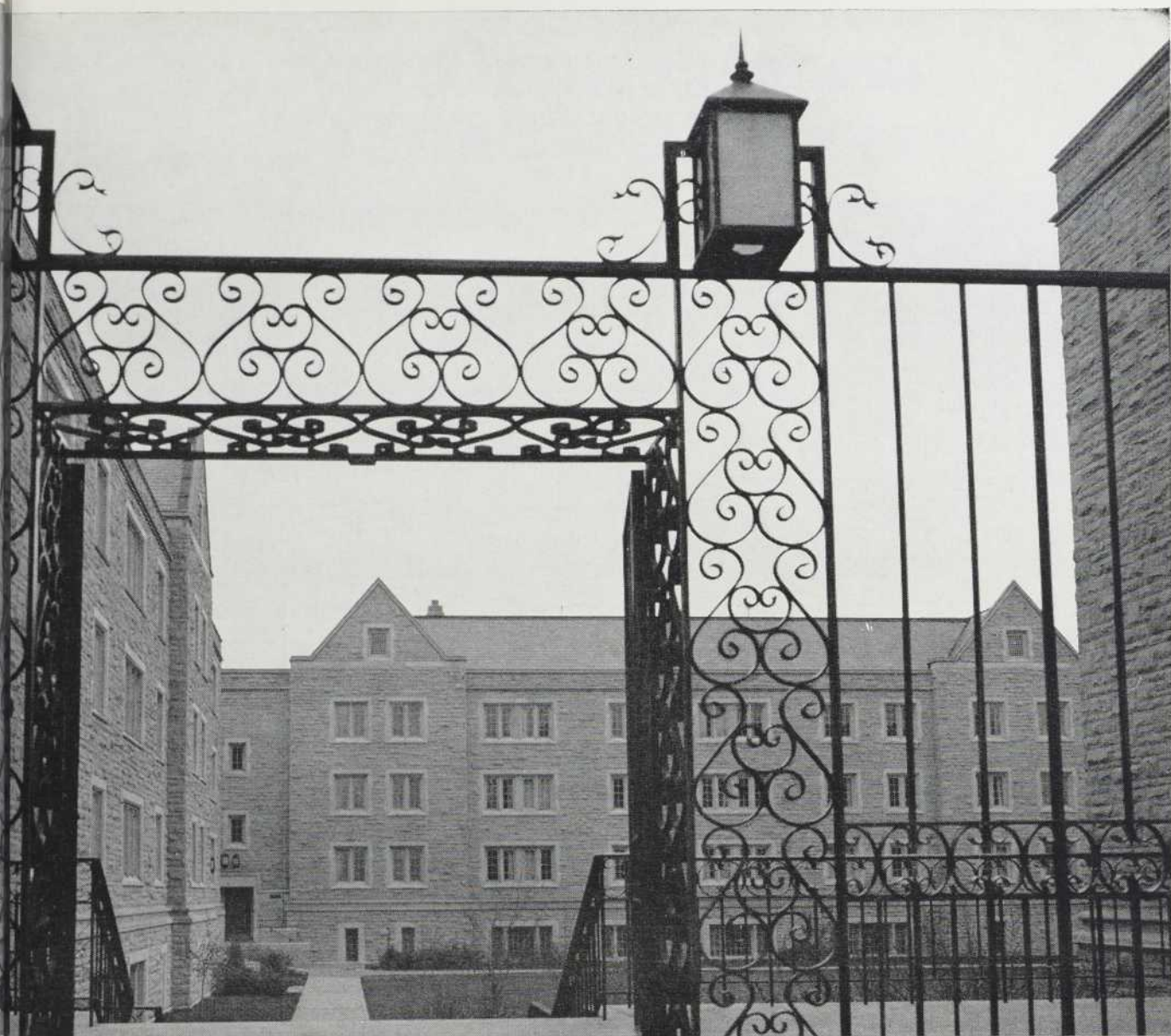
A l'instar des autres immeubles sur le campus toujours grandissant du University of Western Ontario, à London, la résidence des hommes, Sydenham Hall, est entièrement climatisée par Trane. Propriétaire: University of Western Ontario. Architecte: Ronald E. Murphy, London. Ingénieurs conseils: M.M. Dillon & Co. Limited, London. Entrepreneur général: Ellis-Don Limited, London. Entrepreneur en mécanique: Canadian Comstock Company Limited.
