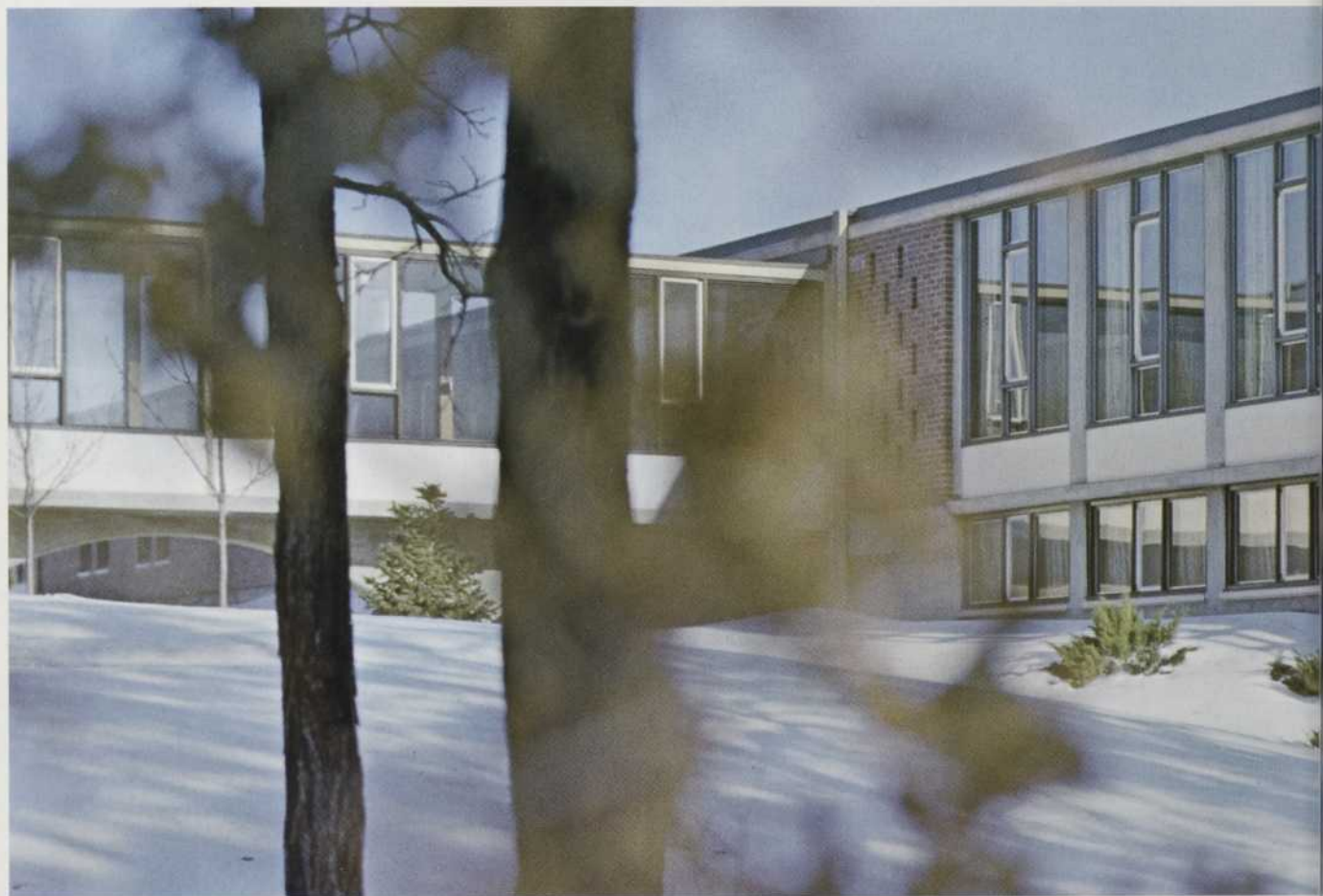
Centre d'Entraînement du Minnesota pour la Police des Routes et la Défense Civile. Architectes: Bettenburg, Townsend, Stolte & Comb. Fenêtres: Andersen à Battant et chassis fixes. glass.
