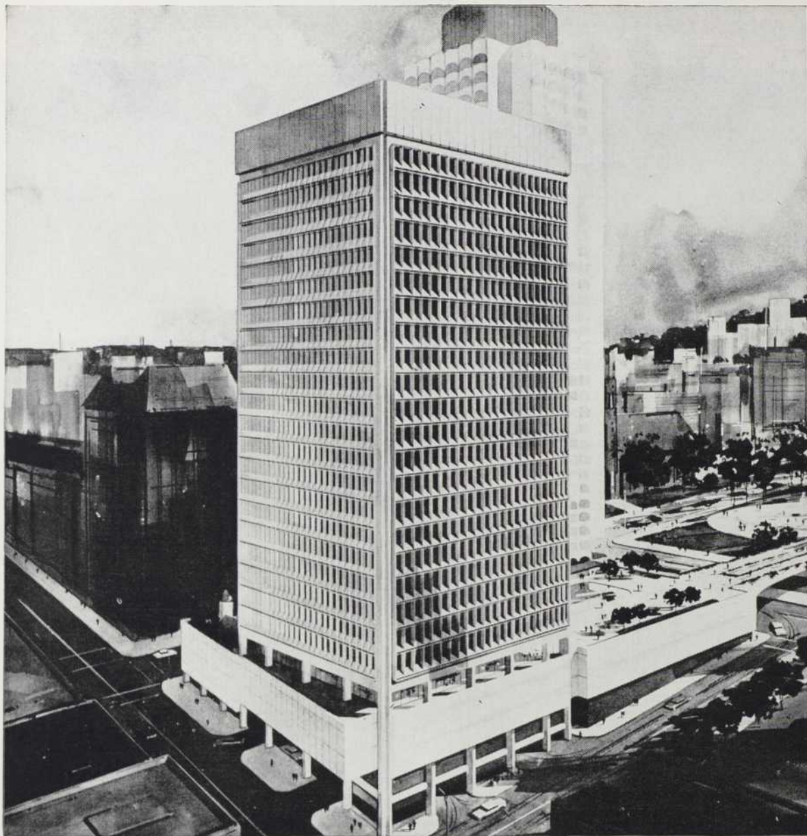
L'imposant immeuble que le Pacifique Canadien vient d'ériger dans le panorama montréalais, Place du Canada, offrira, à ses occupants une température confortable grâce à l'équipement Trane. Propriétaire: Foundation Scottish Properties Ltd., Architectes et ingénieurs: John B. Parkin Associates, Toronto, Los Angeles, Montréal et Sault Ste-Marie. Entrepreneur général: The Foundation Company of Canada Limited. Entrepreneur en mécanique: Canadian Comstock Company Limited.
