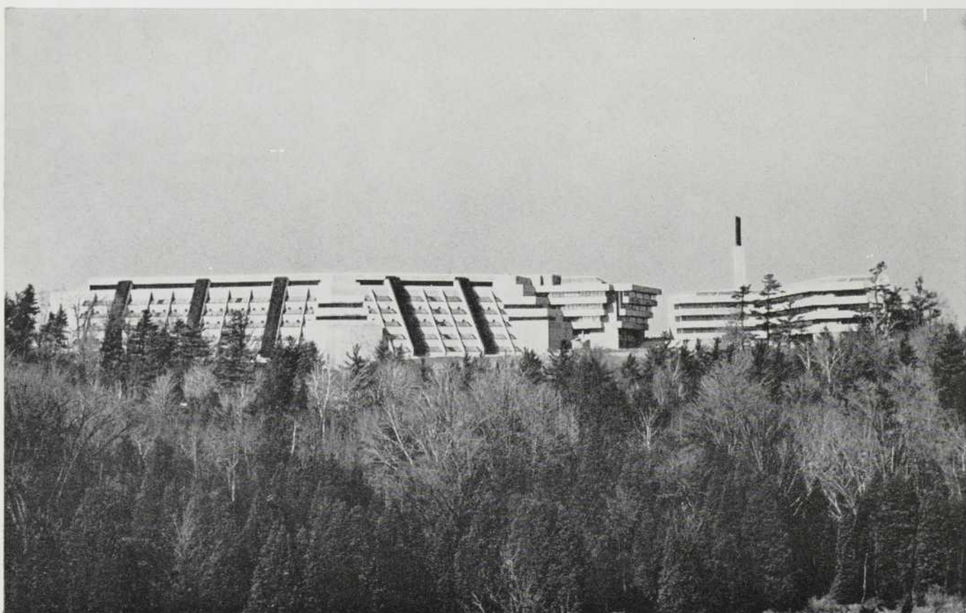
Architectes: Page & Steele et John Andrews. Ingénieurs-conseils: Ewbank Pillar et Associates, Ltd. Entrepreneur Général: E.G.M. Cape Co. (1956) Ltd. Toutes ces entreprises sont de Toronto, Ontario.
