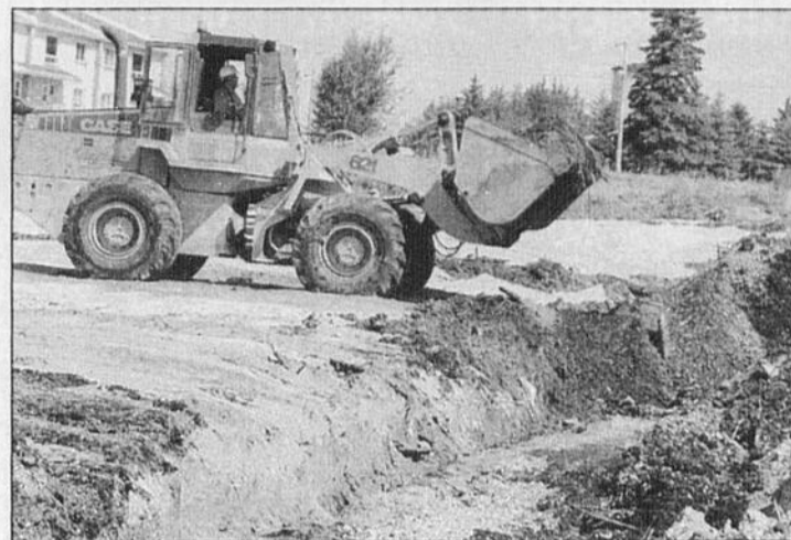
TRAVAUX - Le ministère de l'Environnement a poursuivi hier la réhabilitation du dépôt de matériaux secs de Shipshaw, une seconde étape qui pourrait porter le coût total de l'entreprise à quelque 250 000 $.
