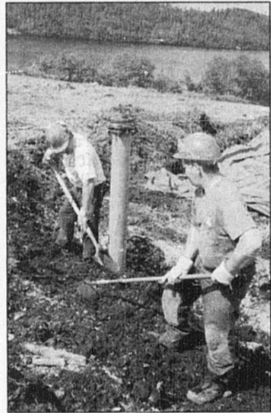
RECOUVREMENT - Des employés effectuent des travaux de recouvrement des matériaux secs sur le site de Shipshaw. (Photo Jeannot Lévesque)
