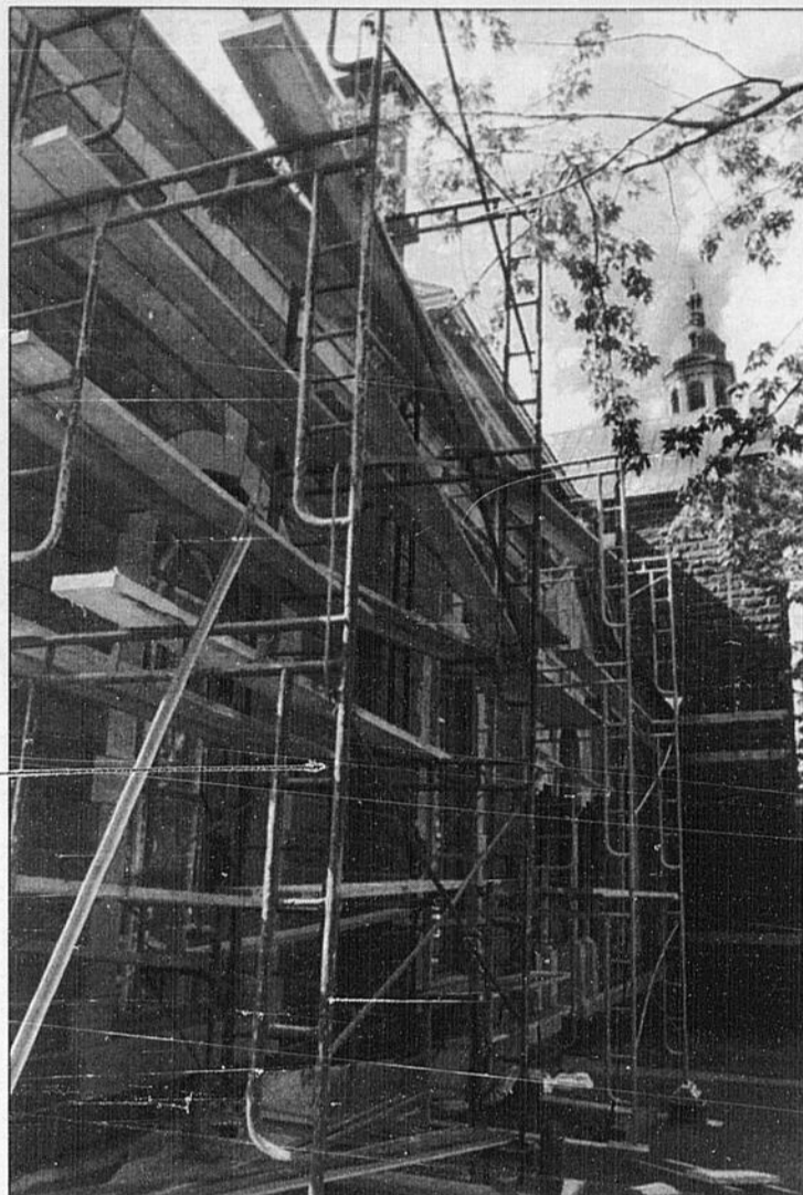
TRAVAUX - Afin de refaire tout le mortier unissant les pierres de la Cathédrale de Chicoutimi, on vient d'entreprendre des travaux évalués à 358 000$.
