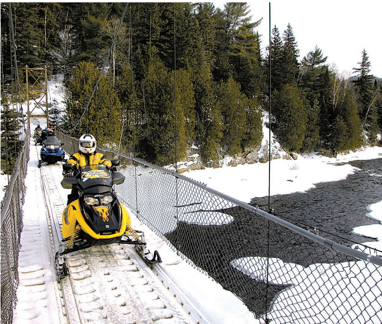
À Notre-Dame-de-la-Merci, un pont suspendu traverse la rivière Ouareau.
