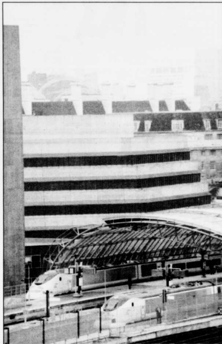
Deux navettes photographiées à leur sortie du tunnel sous la Manche.
