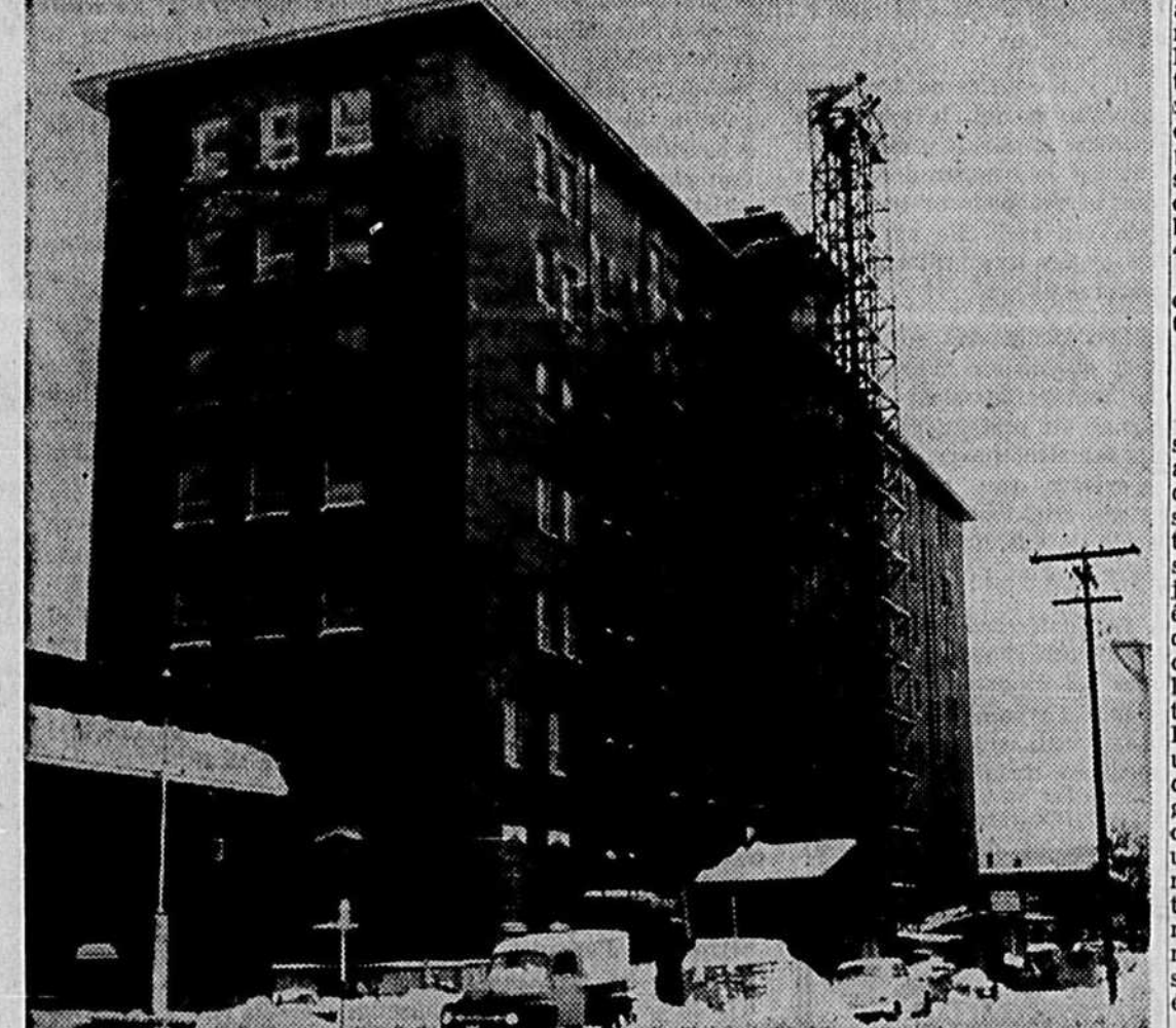
● Cette photographie nous fait voir le futur pavillon que les autorités de l'hôpital St-François d'Assise à Québec font édifier, en ce moment. Cet immeuble de plusieurs étages sera en grande partie affecté à l'école des infirmières de cette institution d'hospitalisation de la Vieille Capitale. La construction s'élève sur la rue Leclerc. (Photo "L'Action Catholique", Roger Bédard.)
